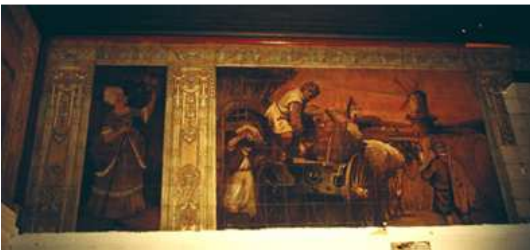
Deel van de achterwand van de winkel van De Gruyter kort voor de sloop.
